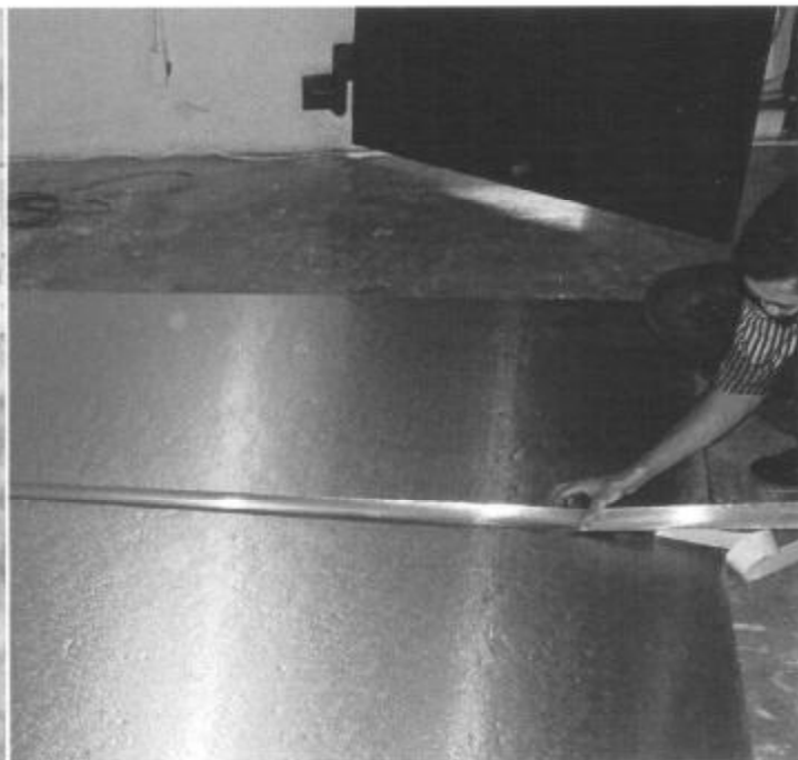
Foto 4: Aplicação de fita metalizada na junção entre placas.
