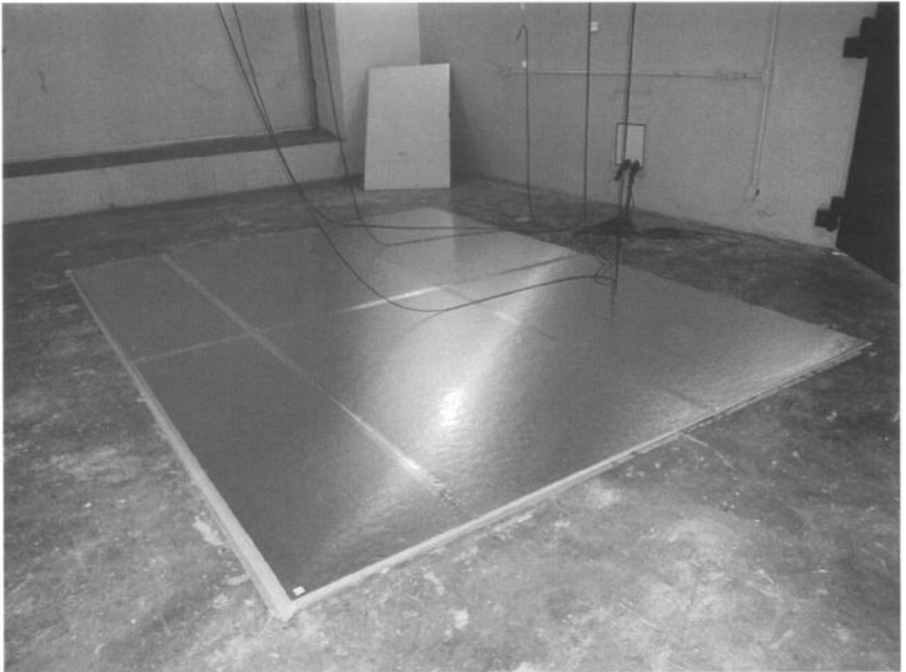
Foto 5: Montagem do item no piso da câmara reverberante.
